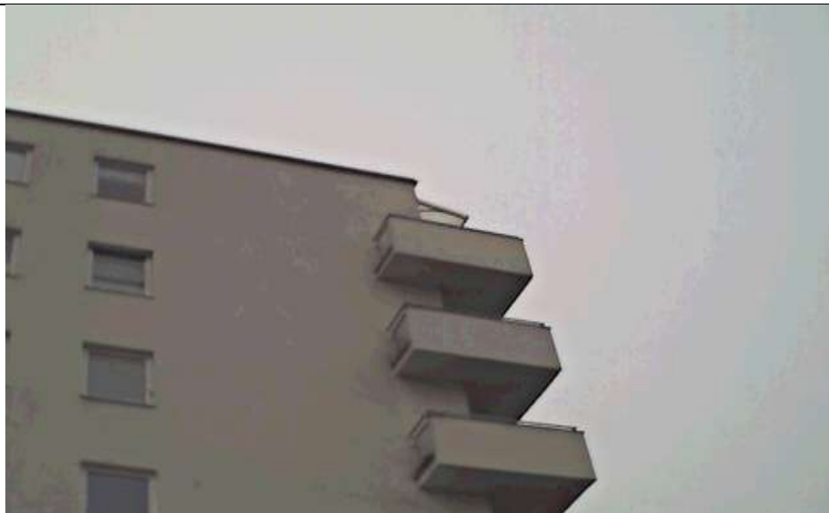
Foto č. 18: Detail průniku balkónové desky fasádou . Reálný snímek termovizní kamerou Zdroj: Fotodokumentace z místního šetření
