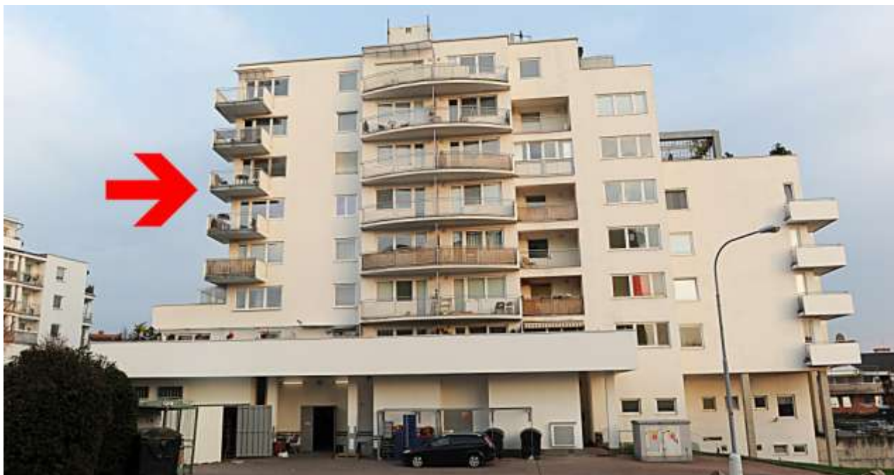
Foto č.1: Západní fasáda bytového domu s prodejnou Billa, Podpěrova 6, Brno - Medlánky Zdroj: Fotodokumentace z místního šetření
