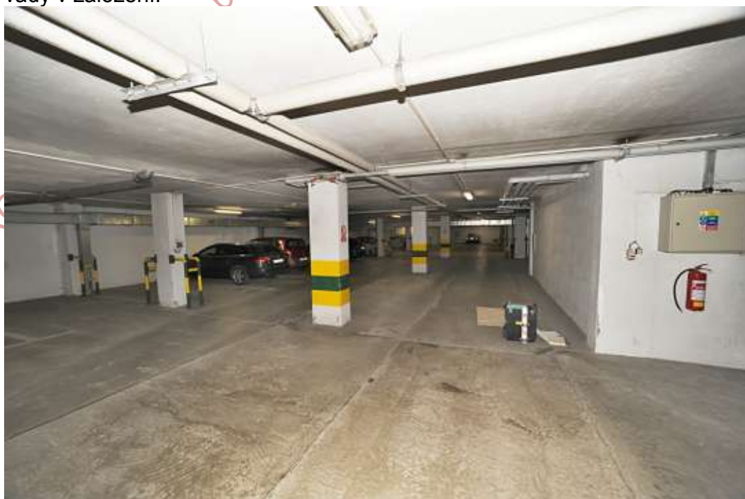
Foto č.3: 1.PP – podzemní garáže. Betonové podlaha ani stropní konstrukce nevykazuje vady způsobené případným poklesem založení objektu Zdroj: Fotodokumentace z místního šetření
