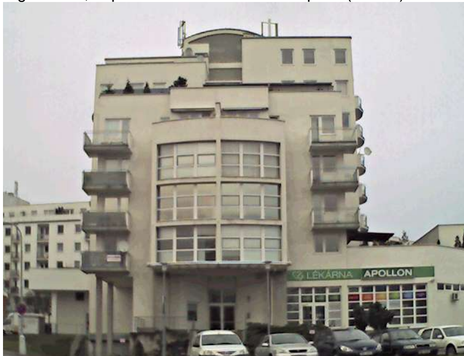
Foto č.10: Jižní fasáda. Reálný snímek termovizní kamerou Zdroj: Fotodokumentace z místního šetření
