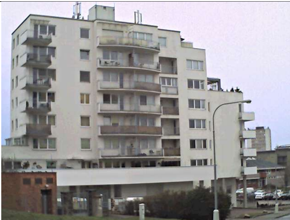
Foto č. 12: Západní fasáda. Reálný snímek termovizní kamerou Zdroj: Fotodokumentace z místního šetření
