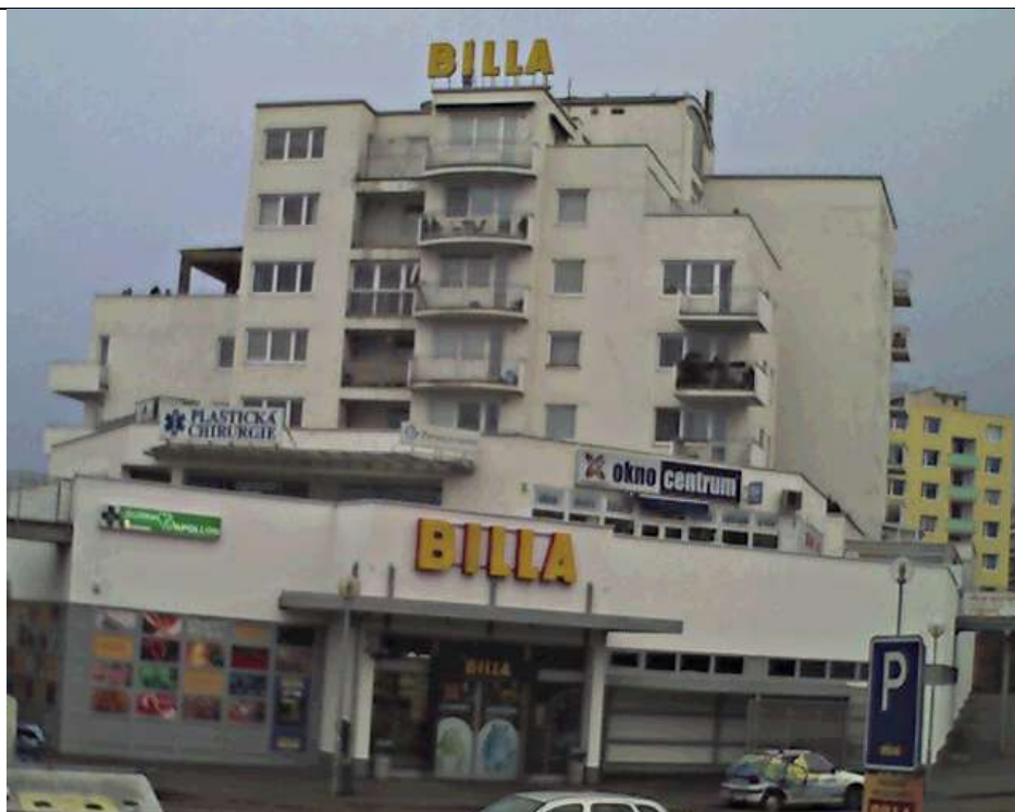
Foto č. 16: Východní fasáda. Reálný snímek termovizní kamerou Zdroj: Fotodokumentace z místního šetření
